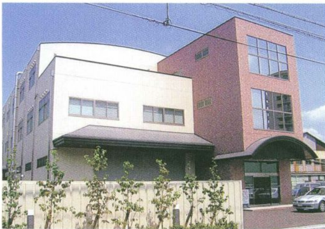
大阪検査所 Osaka Testing Lab
